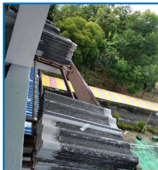
ภาพที่ ๓๓ การปรับปรุงซ่อมแซมหลังคาอาคารเรียน
